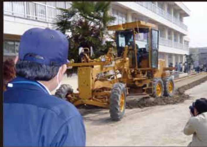
小学校校庭表土除去
