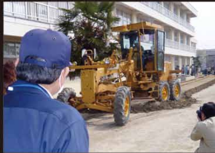
小学校校庭表土除去
